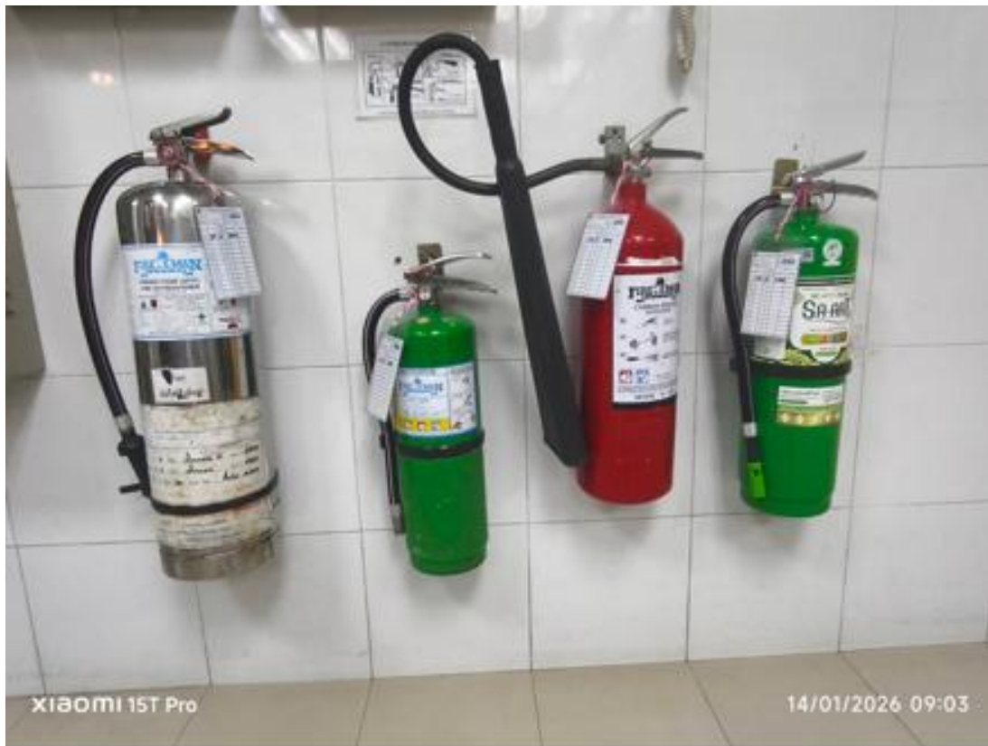
ภาพที่23 แสดงถังดับเพลิงชนิดเคมีผงแห้ง
