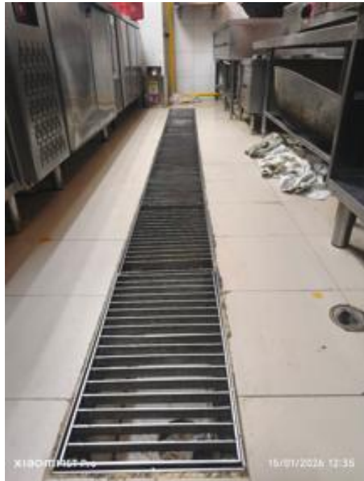
ภาพที่15 แสดงรางระบายน้ำภายในห้องครัว
