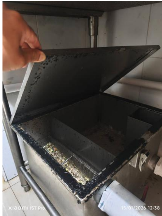
ภาพที่5 แสดงถังดักไขมันเบื้องต้นภายในห้องครัว
